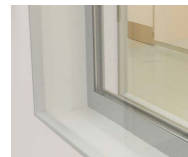
Dvostruko staklo na postojećoj konstrukciji
